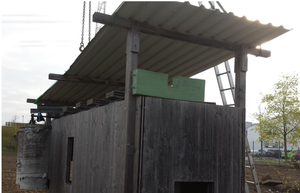
Bild 2 Überdachter „Schuppen“ mit eingebauten Prüfkörpern
