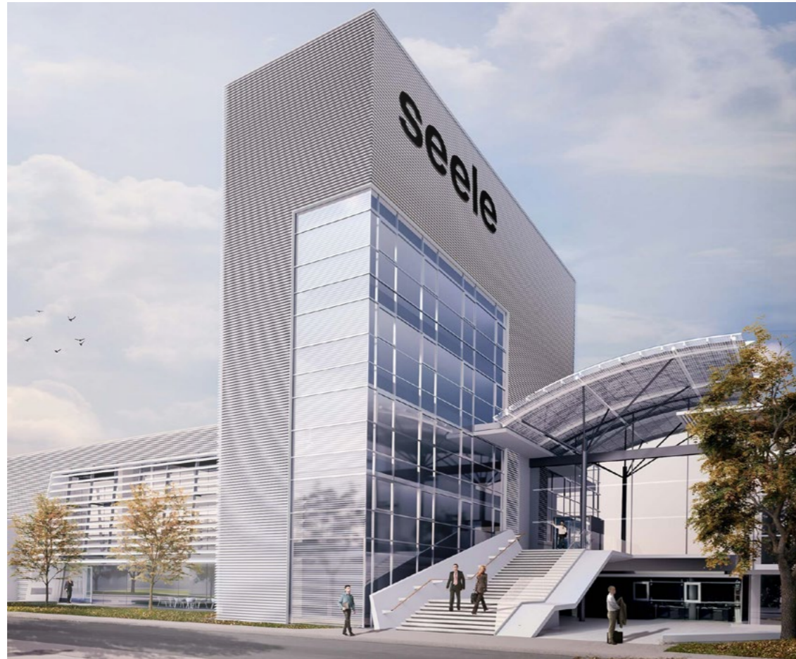
seele Umbau in Gersthofen. Bild: Kergaßner Architekten
