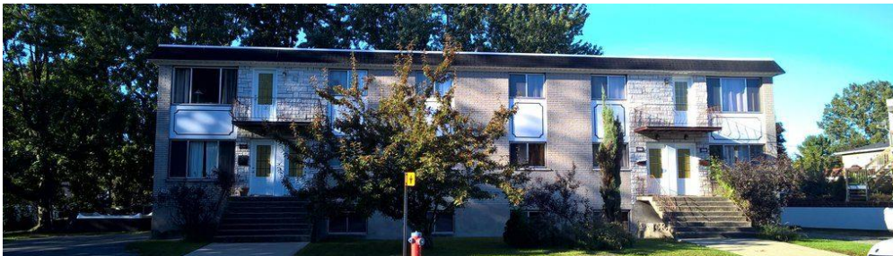
Gebäude des Hébergement Lafond
