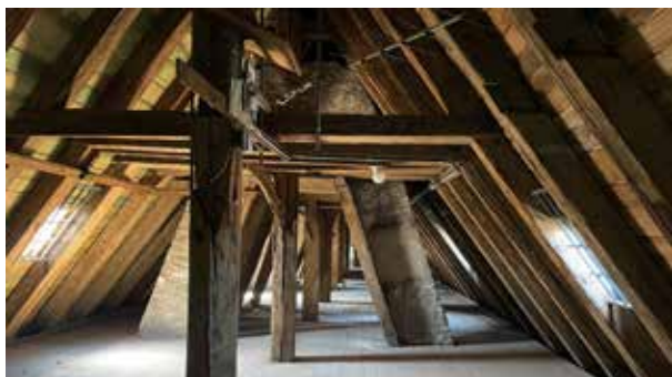
JVA-Gebäude, Dachstuhl des ehemaligen Klosters
