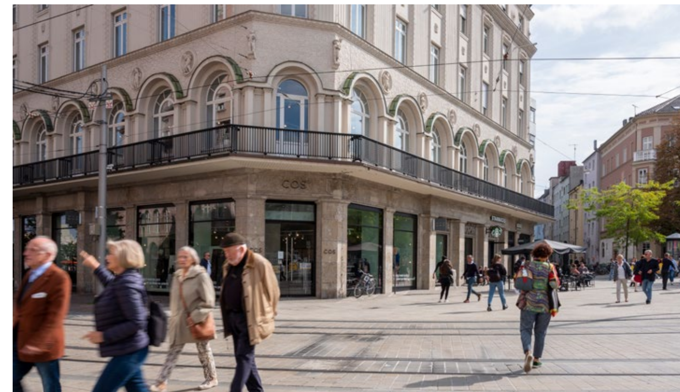
Ein gelungenes Beispiel für eine Mixed-Use-Immobilie in Augsburg ist das ehemalige K&L-Kaufhaus am Königsplatz.
