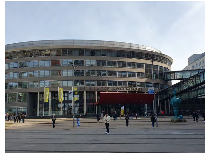
Oval Building von außen.
