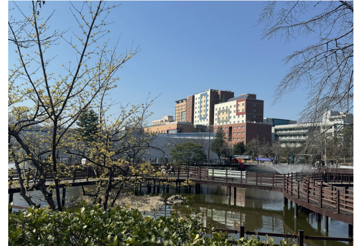
Blick auf das Wohnheim.
