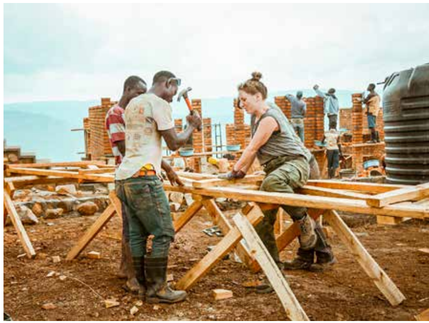
Dachbinder konstruieren Construct roof truss
