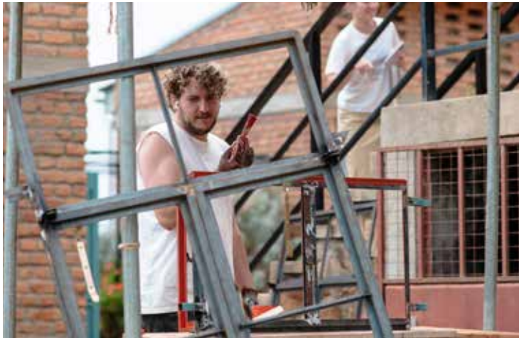
„Malerarbeiten“ painting work
