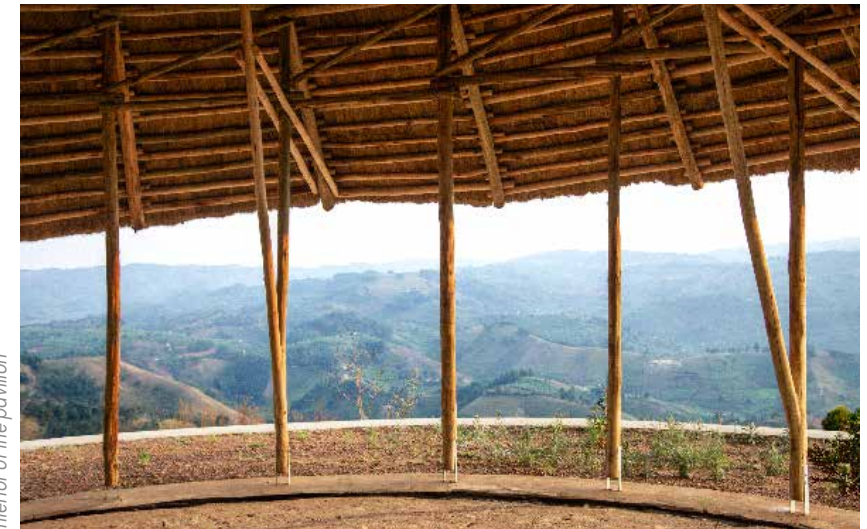
Innenbereich des Pavillons interior of the pavilion
