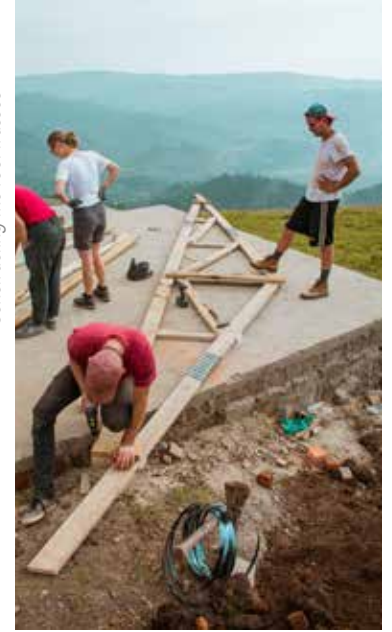
Konstruieren der Dachbinder Constructing the roof trusses
