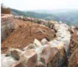
„Erdarbeiten für den Pavillon“
