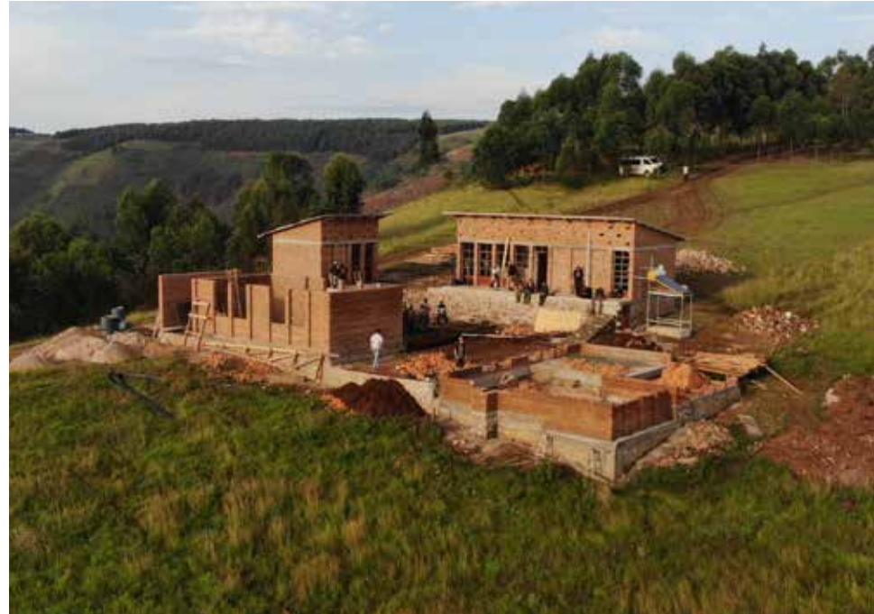
Robbauarbeiten an dem Lern- und Wohncluster Structural work at the learning and living cluster
