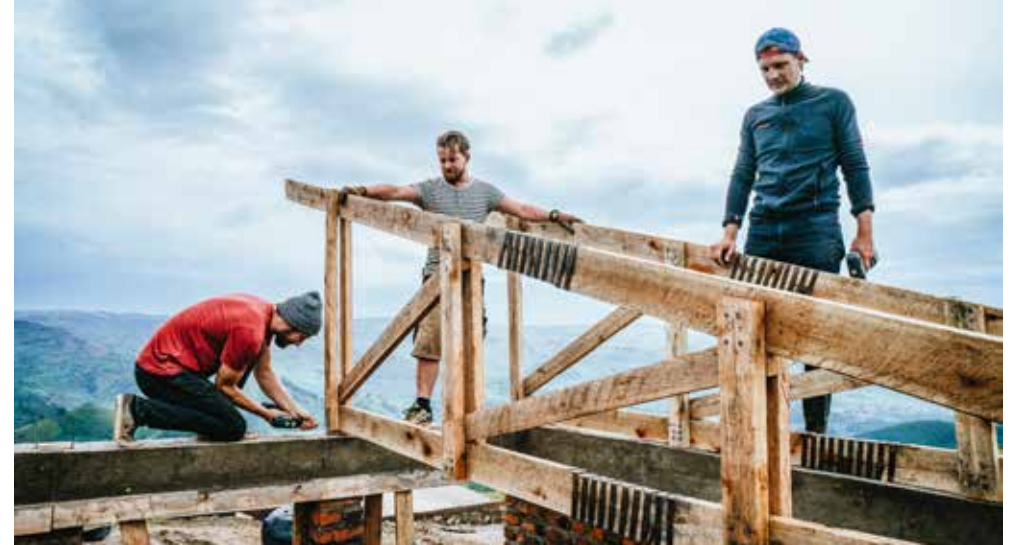
Befestigen der Dachbinder auf dem Ringanker Fixing the rooftrusses to the ring beam
