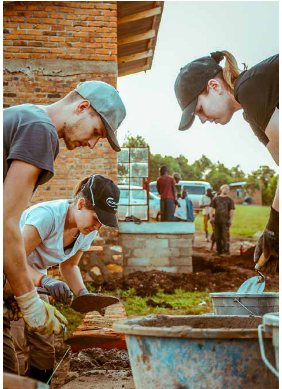
Mauerarbeiten für den Innenhof des Lern- und Wohnclusters Masonry work for the courtyard of the learning and living cluster
