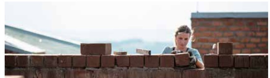
Maurerarbeiten masonry work
