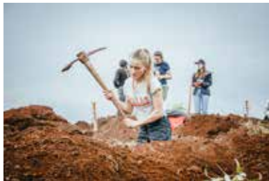
Ausheben der Fundamente Digging the foundations
