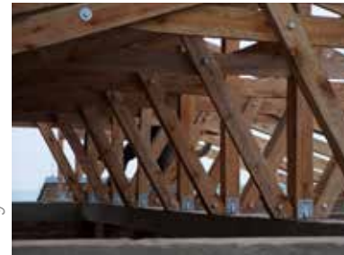
Dachdeckerarbeiten roofing work
