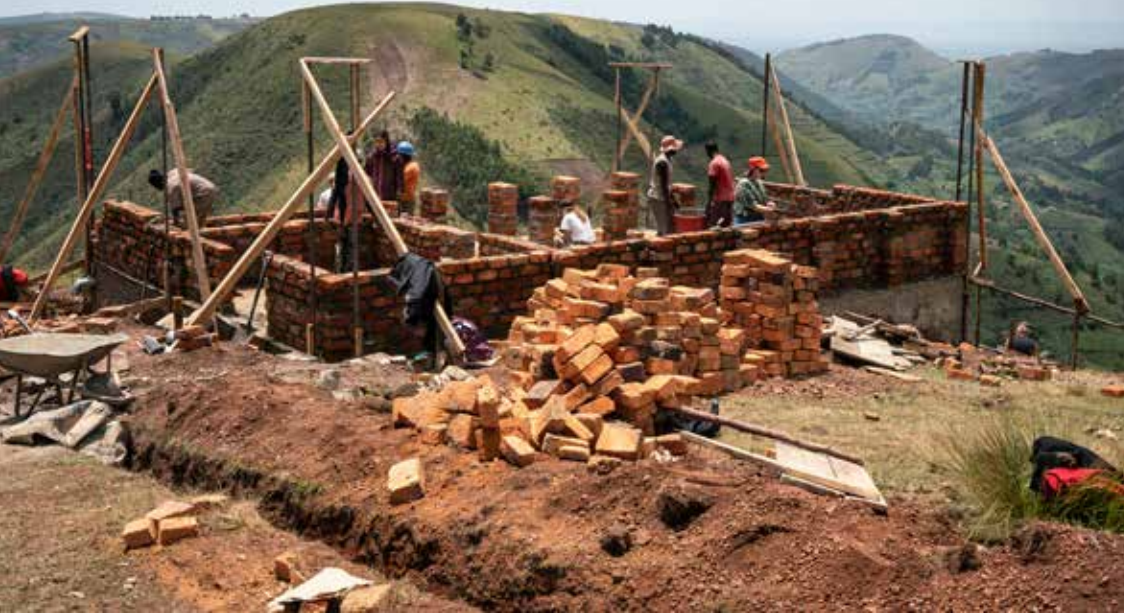
Mauerarbeiten am Gästehaus Brickwork at the guest house
