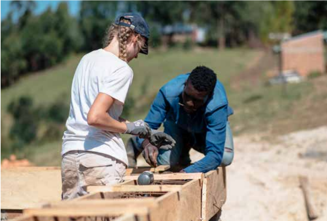
Erstellung des Unterzuges creation of the beam
