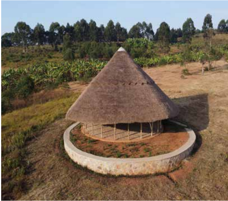
Dachdeckerarbeiten roofing work
