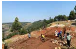
„Erdarbeiten für das dritte Gästehaus“
