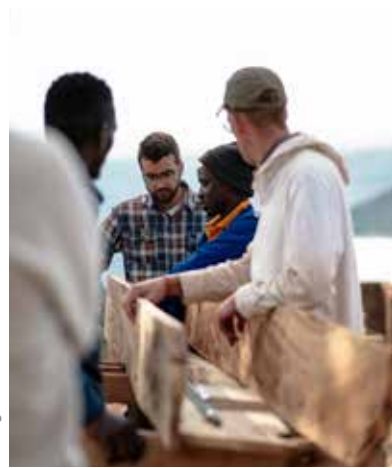
Schalungsetzen setting the formwork
