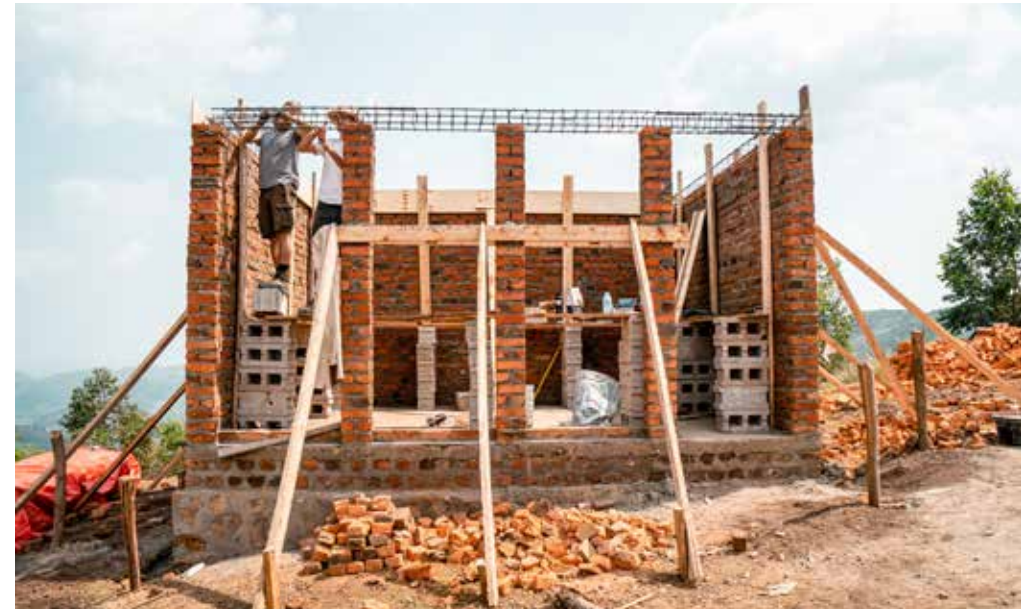
Befestigung der Ringanker-Bewehrung auf den Ziegelstützen und -Mauern Fixing the ring beam armouring to the brick columns and walls
