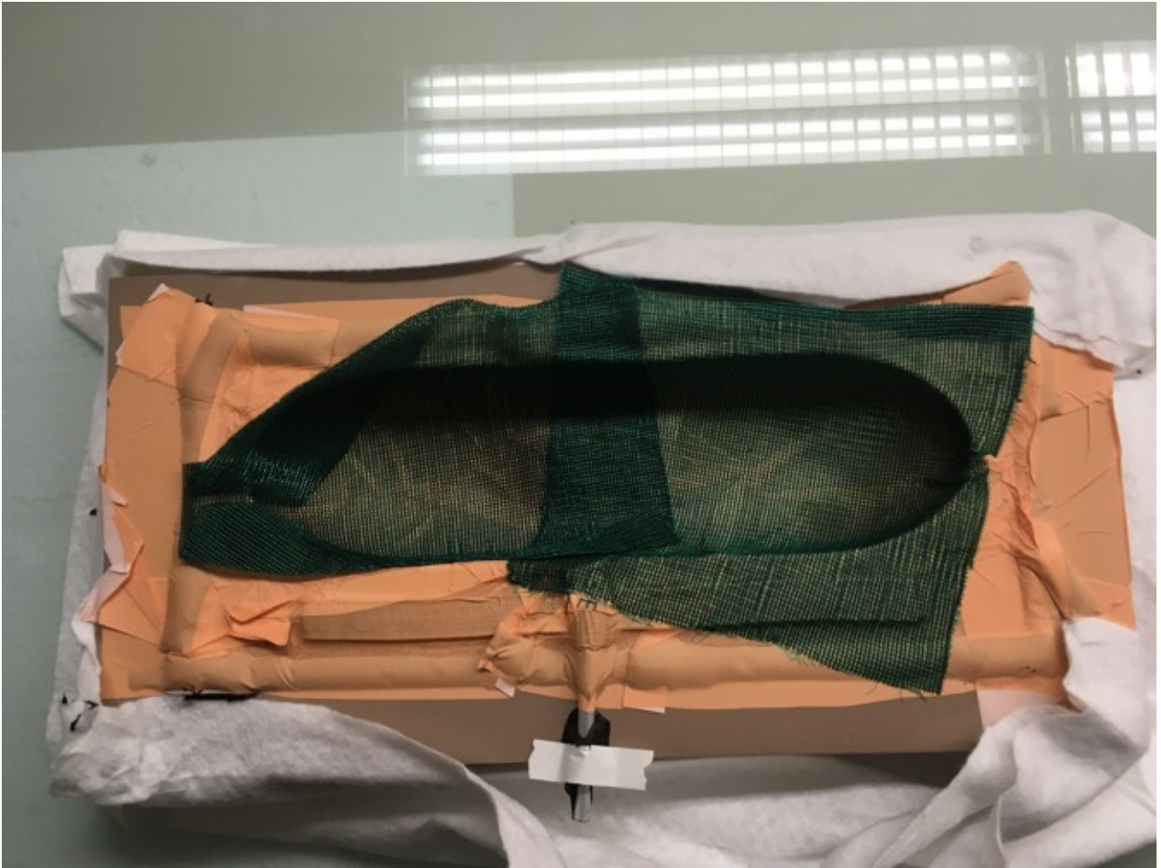
Abbildung 11: Nach Entfernen der Vakuumfolie - OM70 Fließhilfe
