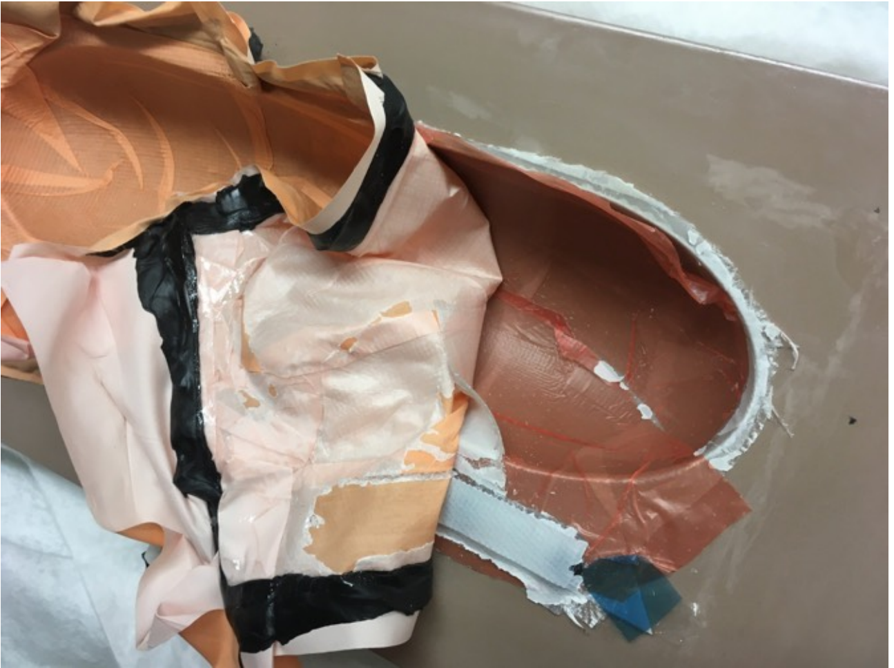
Abbildung 15: Entfernen der VAP Membran
