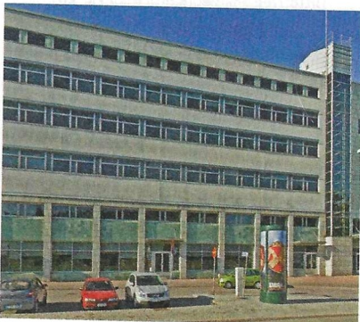
Abbildung 11: Der Arbeitsplatz: Das wenig ansehnliche Universitätsgebäude in der Industriestrasse.
