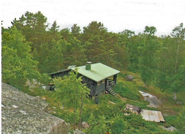
Abbildung 7: Veranda, Terrasse, Solarzellen, alles da. Fast schon luxuriös ist die Ausstattung der Hütte. hinterm Haus ist auch eine Süßwasserquelle.
